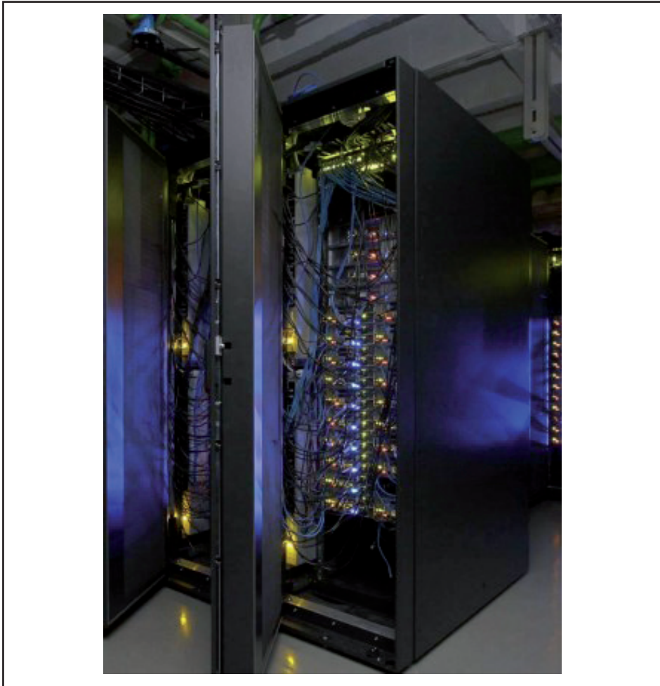
Abbildung 7: Beispiel für Kühlgerät in Rücktür (Hersteller Emerson)
